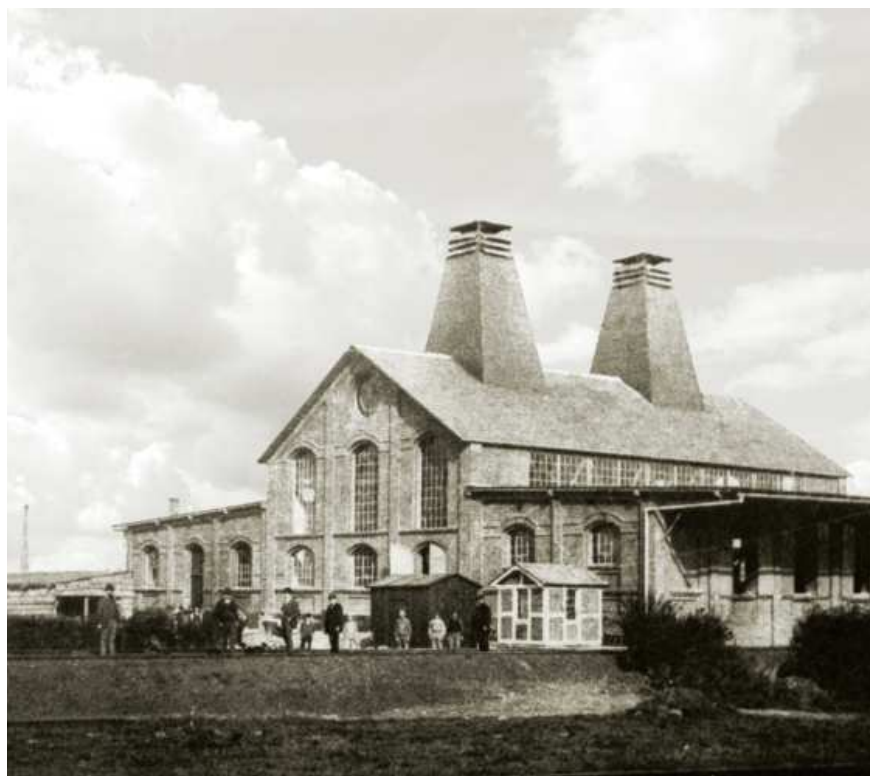
Die erste Gas-Anstalt Unnas an der Friedrich-Ebert-Straße. Sie war von 1860 bis 1897 in Betrieb, danach wurde sie an die Zechenstraße verlegt
