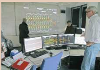
Auch ein Blick auf die Leitwarte ist am Tag der offenen Tür möglich
