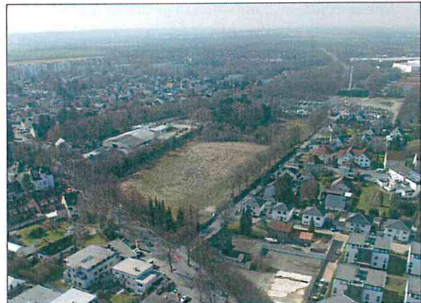
Blick nach Südwesten über das Grundstück
