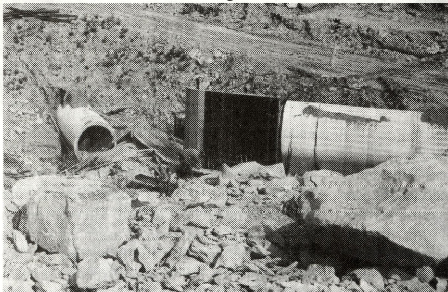
Kanalbau am Büddenberg
