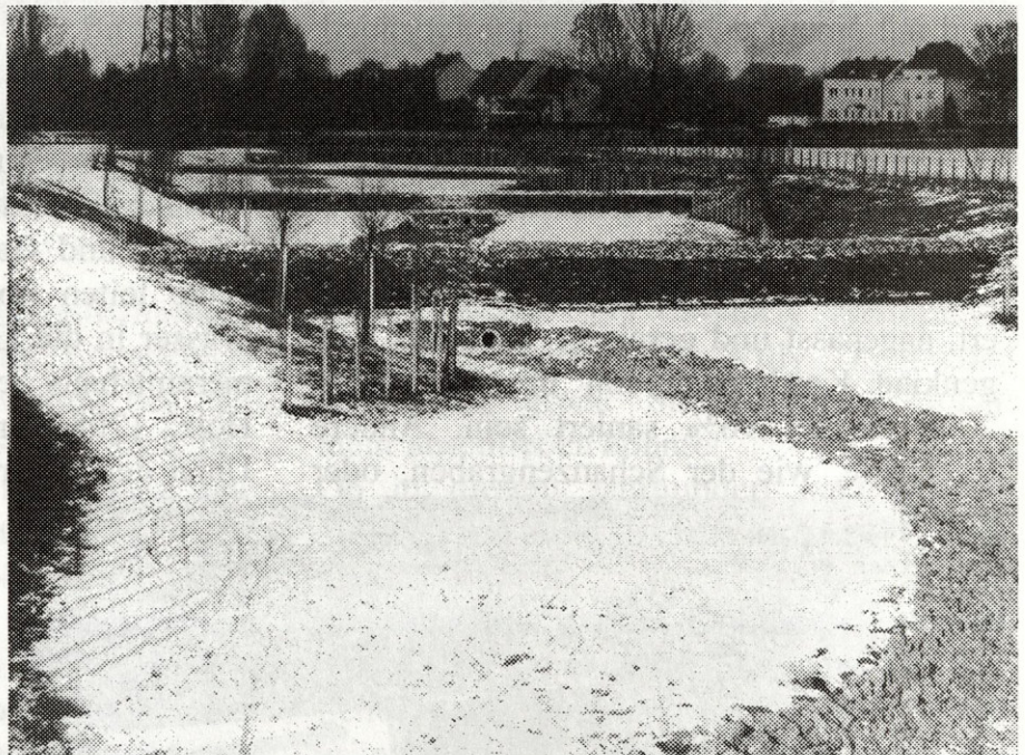
Regenrückhaltebecken entlang der A1 zum Schanzengraben
