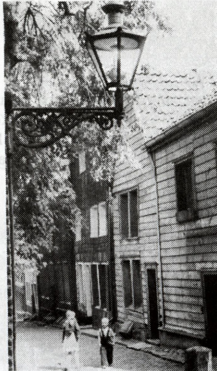
Gaslaterne in der Kirchstraße
