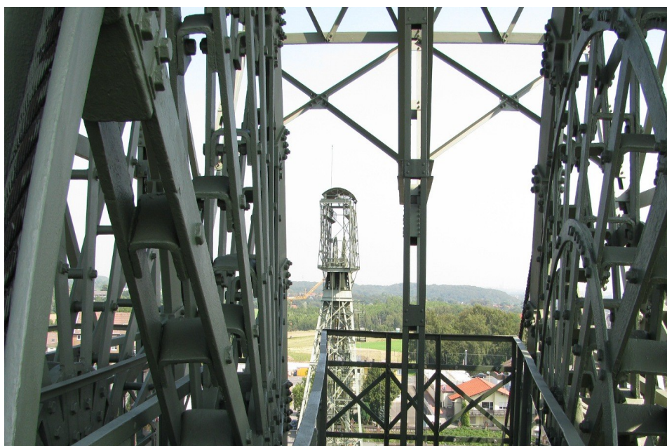
Auf dem Förderturm der früheren Zeche Zollern
