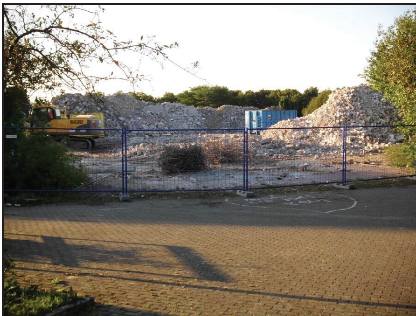
Bild: vom Abriss August 2012, ( www.ausgebadet.de )
