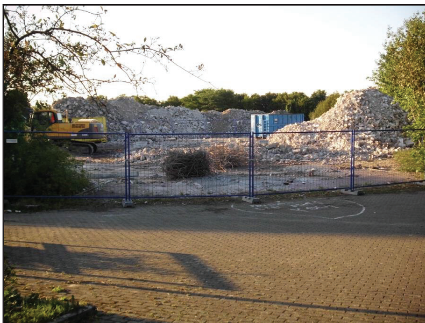
Bild: vom Abriss August 2012, ( www.ausgebadet.de )
