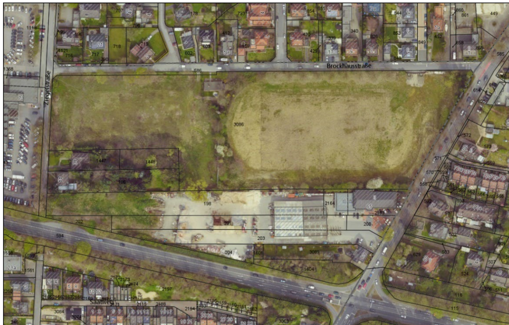
Abb. 1. Luftbild Standort Hertinger Tor, Stand 2017 vor der Sanierung des Trainingsplatzes
