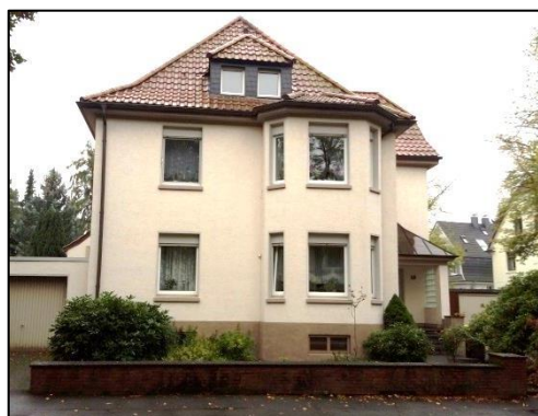
Foto 4: Einfriedung in Form von Mauer 1
