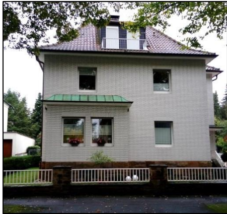
Foto 5: Einfriedung in Form von Mauer in Kombination mit Zaun 1
