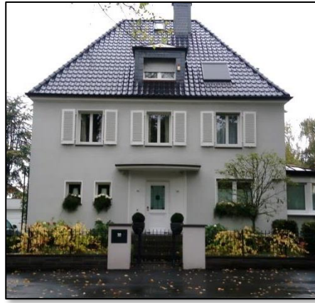
Foto 6: Einfriedung in Form von Mauer in Kombination mit Zaun 1
