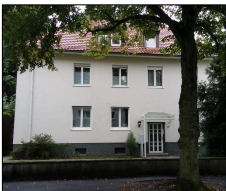
Foto 3: Einfriedung in Form von Mauer 2
