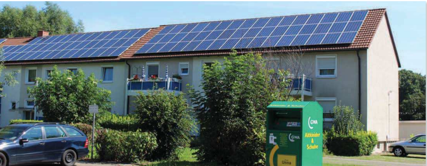
Abb. 18: Gebäudebestand der UKBS an der Hermannstraße nach der Sanierung Fotografie: plan-lokal
