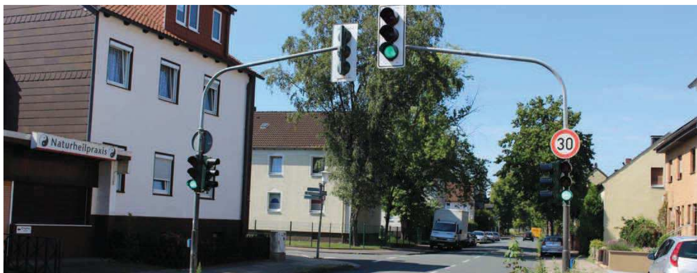
Abb. 15: Gebäudebestand an der Zechenstraße im Teilraum B Fotografie: plan-lokal
