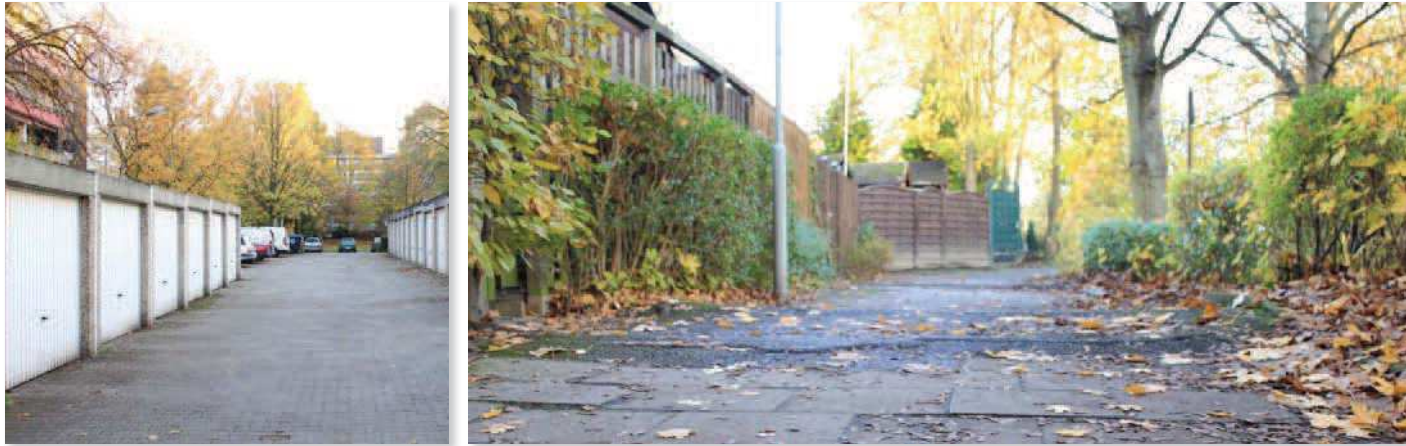
Abb. 27+28: Modernisierungsbedürftige Gehwege und triste Garagenhofsituation im Bereich der Kieler Straße Fotografie: plan-lokal
